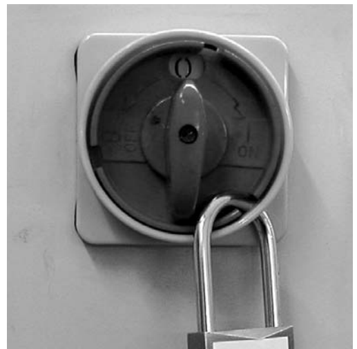
Bild 1: Sicherheitsschalter, der sich mit einem Vorhängeschloss sichern lässt.
