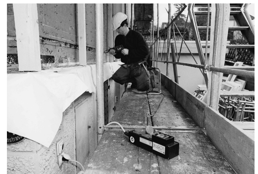
Bild 8: Wenn keine Baustromverteiler vorhanden sind: Mobilen FI-Schutz/RCD einsetzen.
