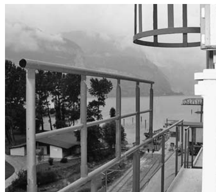
Bild 8: Leitereinstieg auf hoch gelegenem Laufsteg. Das erhöhte Geländer dient als zusätzliche Absturzsicherung
