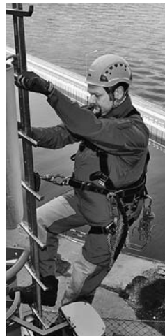
Bild 1: Ortsfeste Leiter mit Mittelholm und Steigschutzeinrichtung. Zum sicheren Begehen von ortsfesten Leitern darf kein Material mit den Händen mitgeführt werden.
