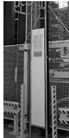
Bild 2: Ortsfeste Leiter mit Rückenschutz. Die Leiter ist mit einer abschliessbaren Sperre gegen unbefugtes Begehen gesichert.
