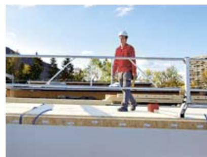
3 Mobiler Seitenschutz für temporäre Absturzstellen an Dachrändern
