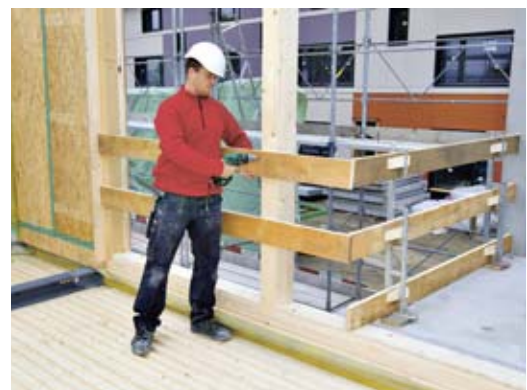
3 Wandöffnung mit Seitenschutz gesichert
