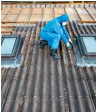
Regel 9 Vor Asbeststaub schützen.
