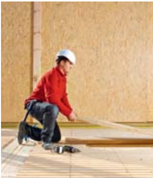
Regel 2 Bodenöffnungen schliessen.
