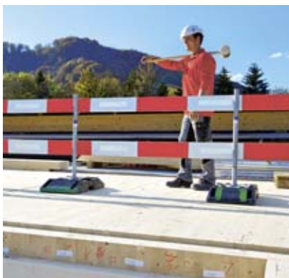
1 Zonenabschränkung: 2 Meter von der Absturzkante zurückversetzt
