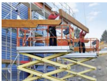
2 Montage von Tragwerken mit Hilfe einer Hebebühne
