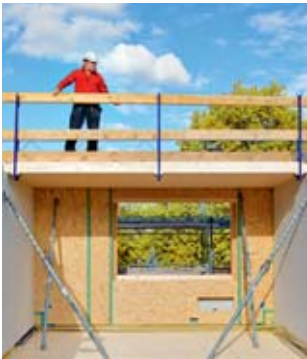
Regel 1 Absturzkanten sichern.
