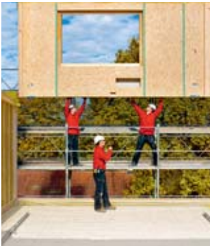
Regel 3 Mit Fassadengerüst arbeiten.
