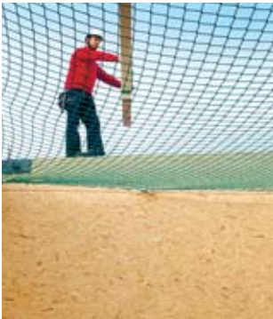
Regel 4 Bei Montagearbeiten Massnahmen treffen.
