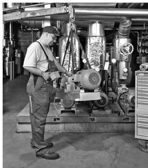
Bild 2: Der Instandhalter benützt die vorgegebenen Hilfsmittel, hier den Kran.
