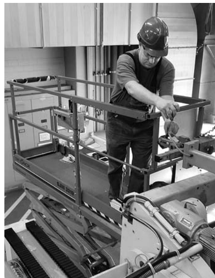
Bild 5: Für die Schmierarbeit in der Höhe wird eine Hubarbeitsbühne verwendet.
