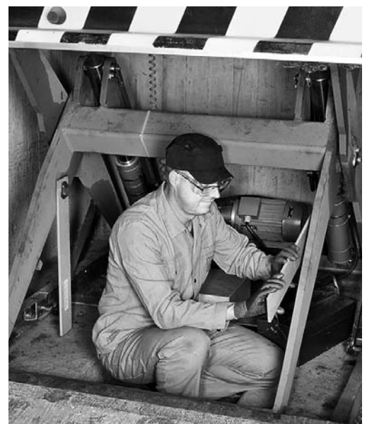
Bild 4: Die angehobene Hebebühne wird mit Stützen gesichert.
