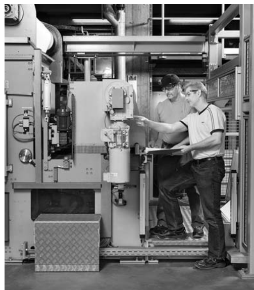
Bild 1: Vorgesetzter und Mitarbeiter ermitteln die Gefahren an der Anlage.
