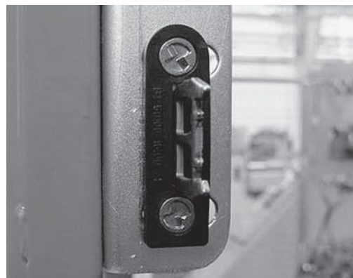
Bild 4: Missbrauch verhindern, z. B. mit nicht lös-baren Schrauben.
