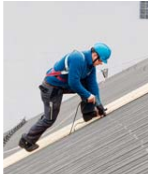
Regel 3 Durchbruchssichere Dachflächen.
