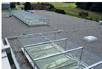
2 Oblichter aus Kunststoff, mit Kollektivschutz gesichert
