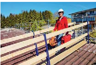
1 Wellplattendach aus Faserzement, mit Laufsteg gesichert
