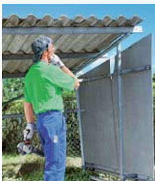
Regel 7 Asbeststaub vermeiden.
