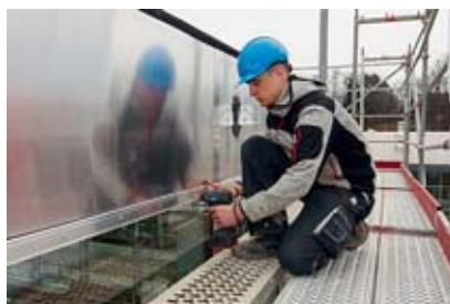
2 Gerüst mit Konsolen bei zu grossem Fassadenabstand
