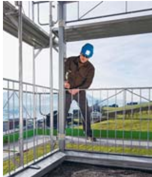
Regel 2 Gerüste täglich kontrollieren.
