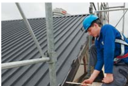
1 Abstand zwischen Gerüst und Fassade: max. 30 cm
